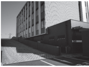
2階に乗り入れるスロープ
